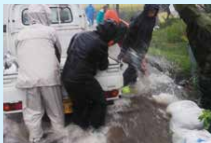
大分県由布市消防団 積み土のう工を実施 (令和4年9月17日～22日：光永宮川付近)
