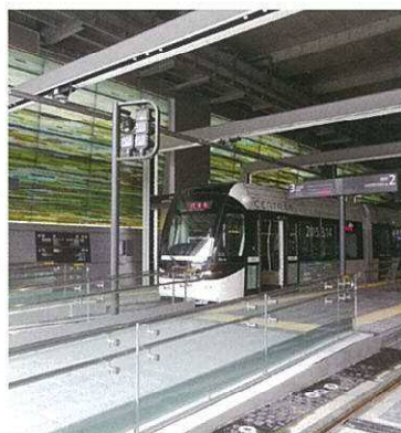
路面電車の富山駅高架下乗り入れ
